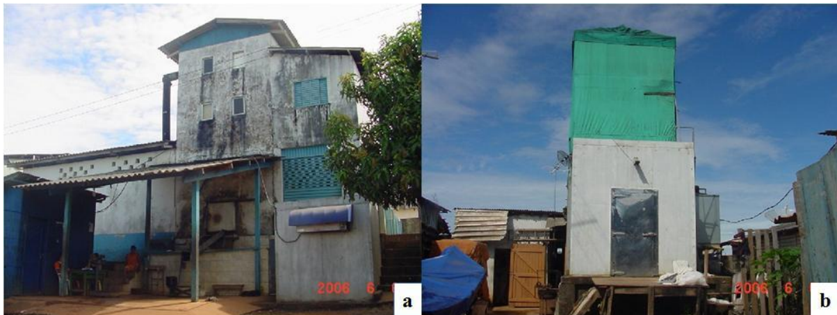
Figura 10. Vista das fábricas de de Gelo E (a) e Fábrica de Gelo F (b), em Tucuruí.
