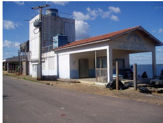
Figura 8. Vista da Fábrica de Gelo D, município de Breu Branco.
