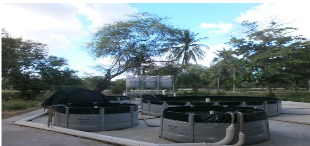
Figura 1. Vista dos tanques pré-moldados no Centro de Desenvolvimento e Difusão de Tecnologia em Aquicultura-CDDTA, UNEB, Paulo Afonso, estado da Bahia.
